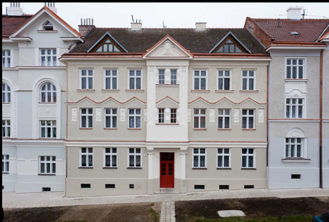
Antonín Dvořák, Kubistické domy na ulici Dobrovského v Brně, 1920, obnova fasád, Tomáš Rusín, Ivan Wahla a Alžběta Sukačová, Atelier RAW, 2011, foto David Židlický
